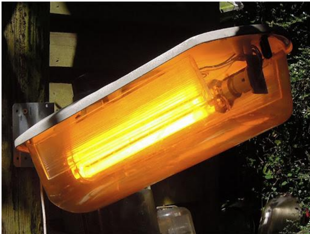
Figuur 107: SOX lamp in straatverlichting armatuur
